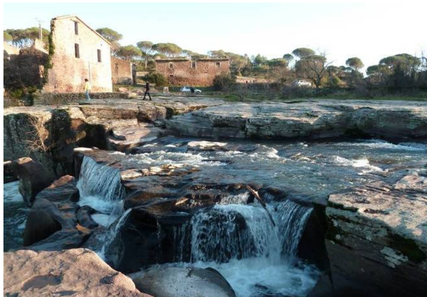
Ancienne scierie – Commune de Vidauban
