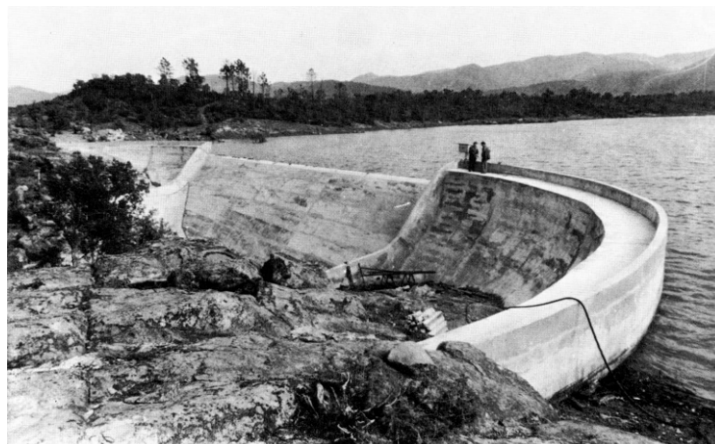
Photo du barrage à sa construction (Nice-Matin)
