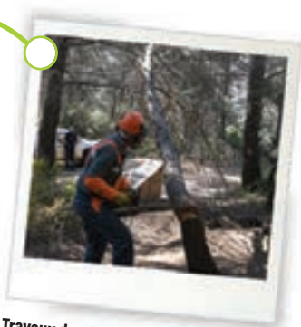
Travaux de mise en sécurité : abattage
