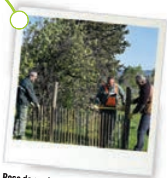
Pose de ganivelles...
