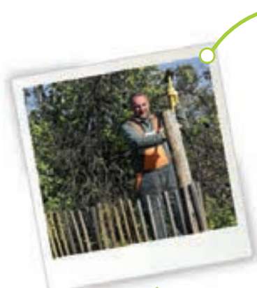
L'aménagement Pose de signalétique
