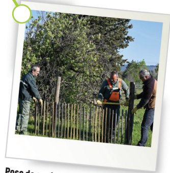
Pose de ganivelles...
