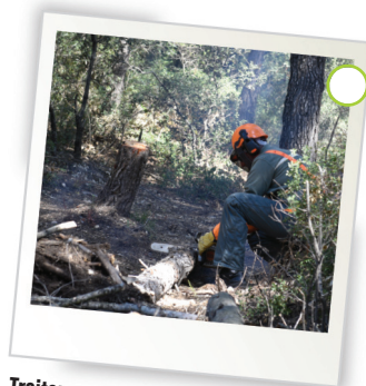
Traitement des embâcles
