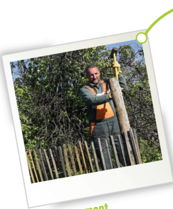
L'aménagement Pose de signalétique
