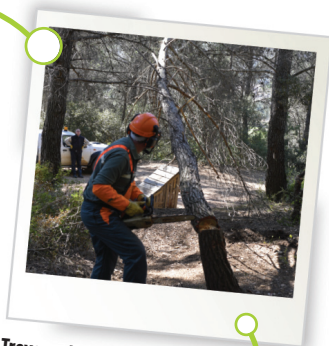
Travaux de mise en sécurité : abattage
